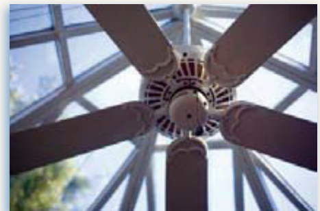
Figura 7.32. Un ventilador de techo.
