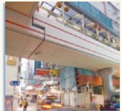
Figura 5.7. Detalle de la escalera eléctrica más grande del mundo.
